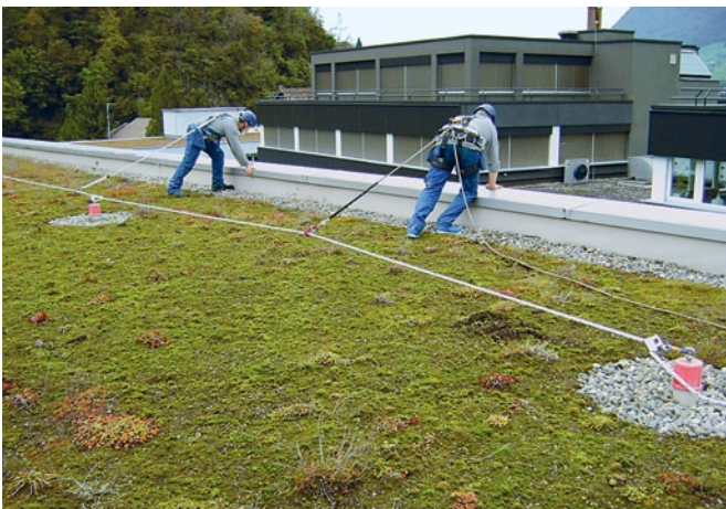
Abb. 10: Temporäres Seilsystem mit Karabinerhaken an EAP befestigt
