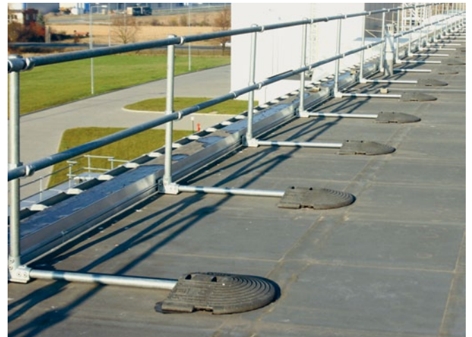
Abb. 16: Ausstattungsstufe 3: Seitenschutzsystem mit Auflast
