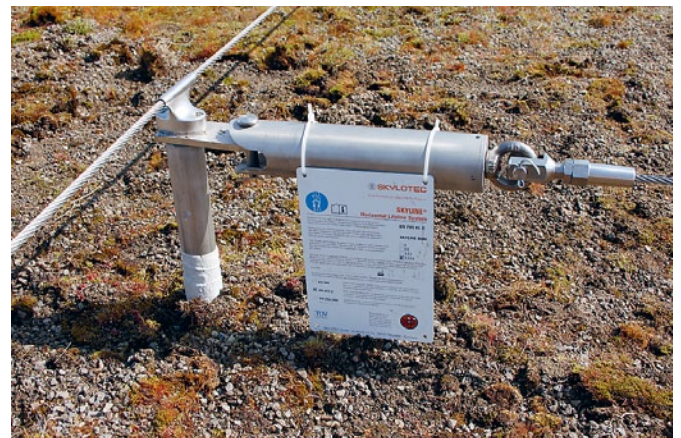
Abb. 24: Objektspezifische Anlagebeschriftung
