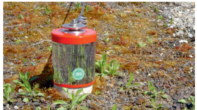
Abb. 25: Objektspezifische Anlagebeschriftung mit Prüfvignette
